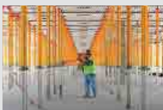
Опалубка для перекрытий
