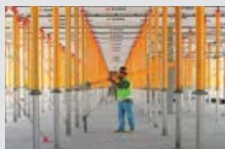
Опалубка для перекрытий
