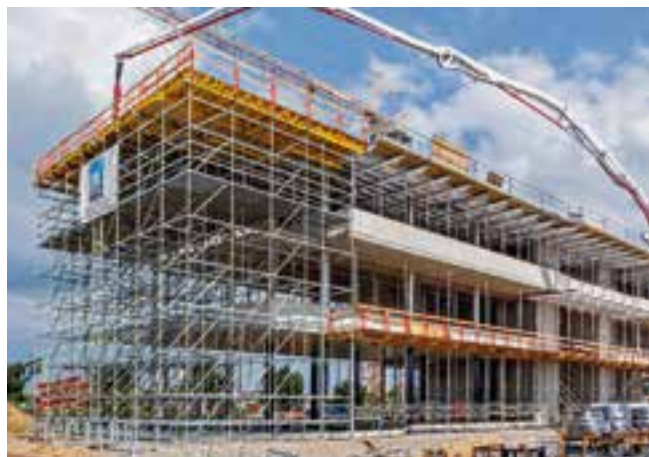
Готовое решение под ключ. Опалубка стен и перекрытий, а также несущие леса и леса для армирования, оптимально подобранные под требования проекта.
