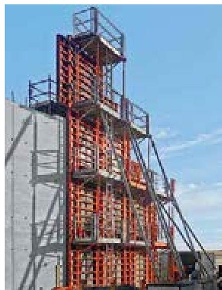
Оснащенная соответствующими системами рабочих платформ, стеновая опалубка TRIO обеспечивает максимальную безопасность для строительной команды. Завершенные, крупногабаритные подвижные установки с рабочими платформами, лестницы и ограждения могут перемещаться от одного цикла к другому.
