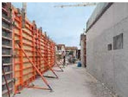
TRIO Structure— это вариант проверенной системы рамной опалубки, который может использоваться полным набором дополнительных приспособлений TRIO.
