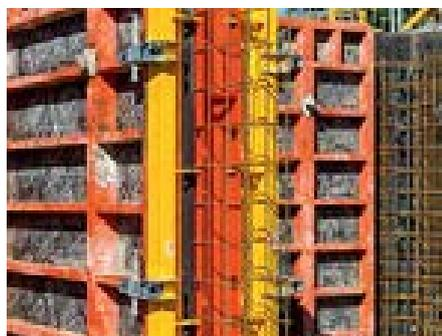
При непрерывном армировании для следующих операций по бетонированию используется панель TRIO Stopend Panel MT.
