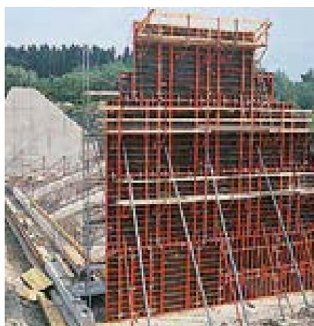
Для бетонирования на высоту до 3,30 м, необходимо только два анкера, в то время как трех выпрямляющих замков BFD будет достаточно на швах панелей.
