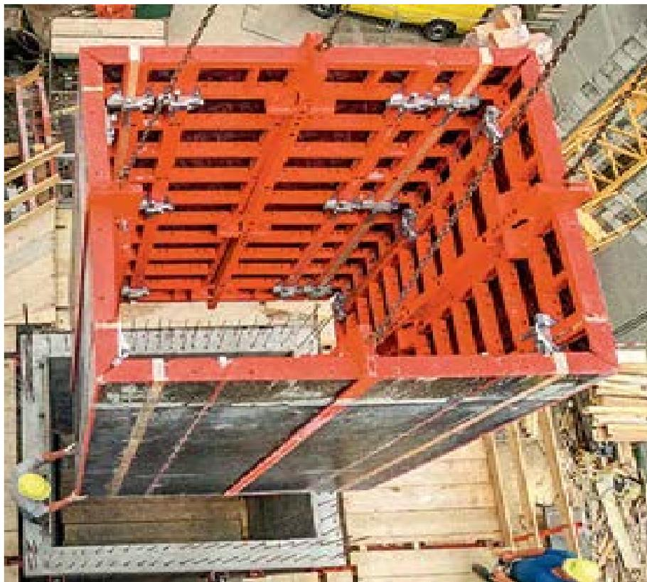
Для прямоугольных шахт нужны регулируемые крановые стропы в связи с разной длиной точек крепления. Это приводит к приблизительно одинаковому усилию растяжения на всех четырех стропях.
