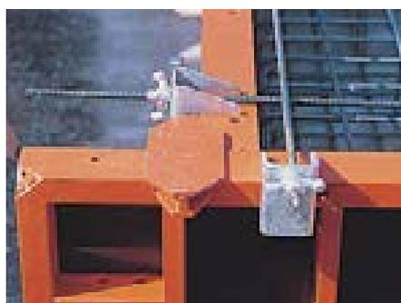
Подвеска для тяжей позволяет выполнить крепление без сетки за пределами элемента. Именно поэтому она используется для создания фундаментов и наращивания элементов.
