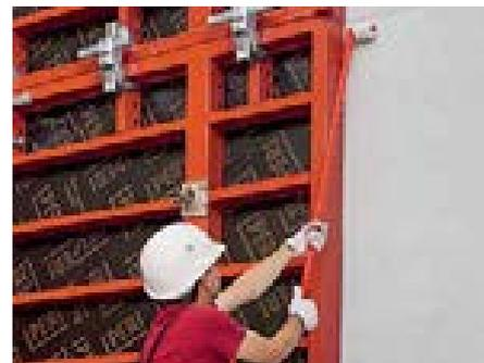
Используя стержень для распалубки, панели можно снять легко и без повреждений. Направляющий ролик также предотвращает повреждение бетонной стены.
