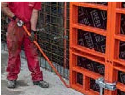
С помощью выравнивающего уголка можно достичь точного положения панели, без применения молотка. Это особенно просто, если вы используете стержни для распалубки.
