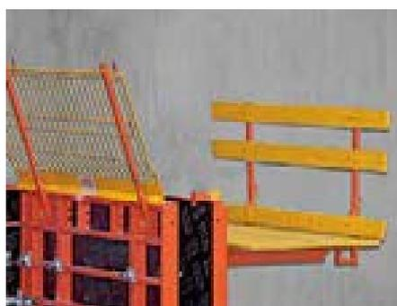
Закрепленная по обеим сторонам платформа обеспечивает рабочую зону, с одной стороны, с другой стороны к ней крепится защита от падения.
