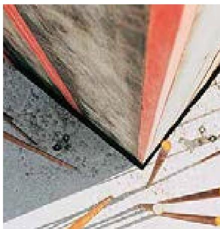
Около 3 см в ширину зазор распалубки отчетливо виден. Сам шахтный элемент остается возле бетона, таким образом, обеспечивая лучшее направление.
