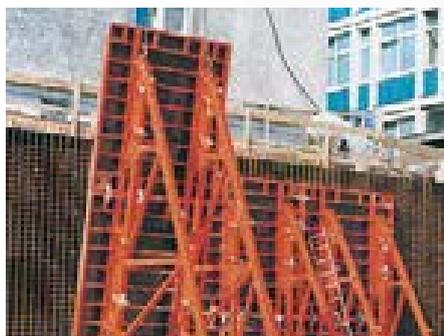
Крепление производится с силовым замыканием, что позволяет перемещение смонтированных единиц в комплекте.
