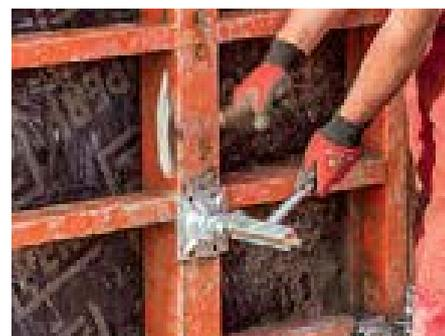
Гаечный ключ анкерного крепления значительно упрощает работу по устройству точек крепления.
