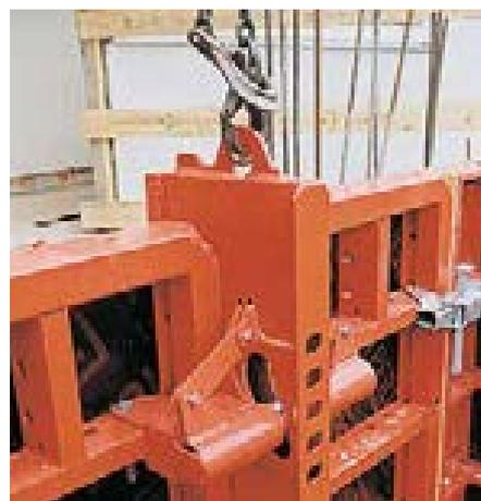
После подъема с помощью крана, шахтный элемент TSE освобождается, что приводит к образованию необходимого зазора распалубки.
