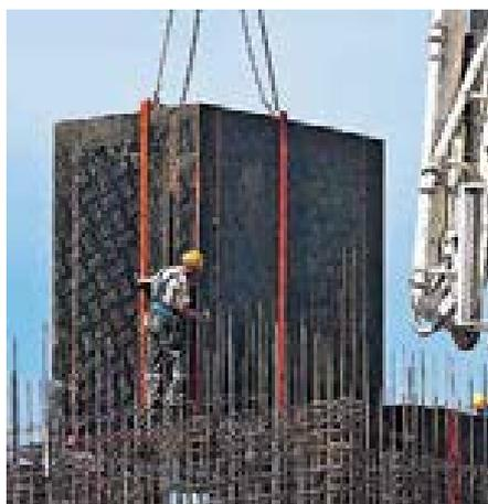
При извлечении шахтных элементов, на каждой стороне обеспечивается зазор распалубки 3 см, и вся установка может перемещаться одним подъемом с помощью крана.
