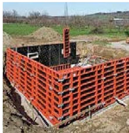
Несколько различных компонентов системы, а также универсальный выпрямляющий замок BFD - который можно устанавливать одной рукой - обеспечивают быструю и легкую установку опалубки TRIO
