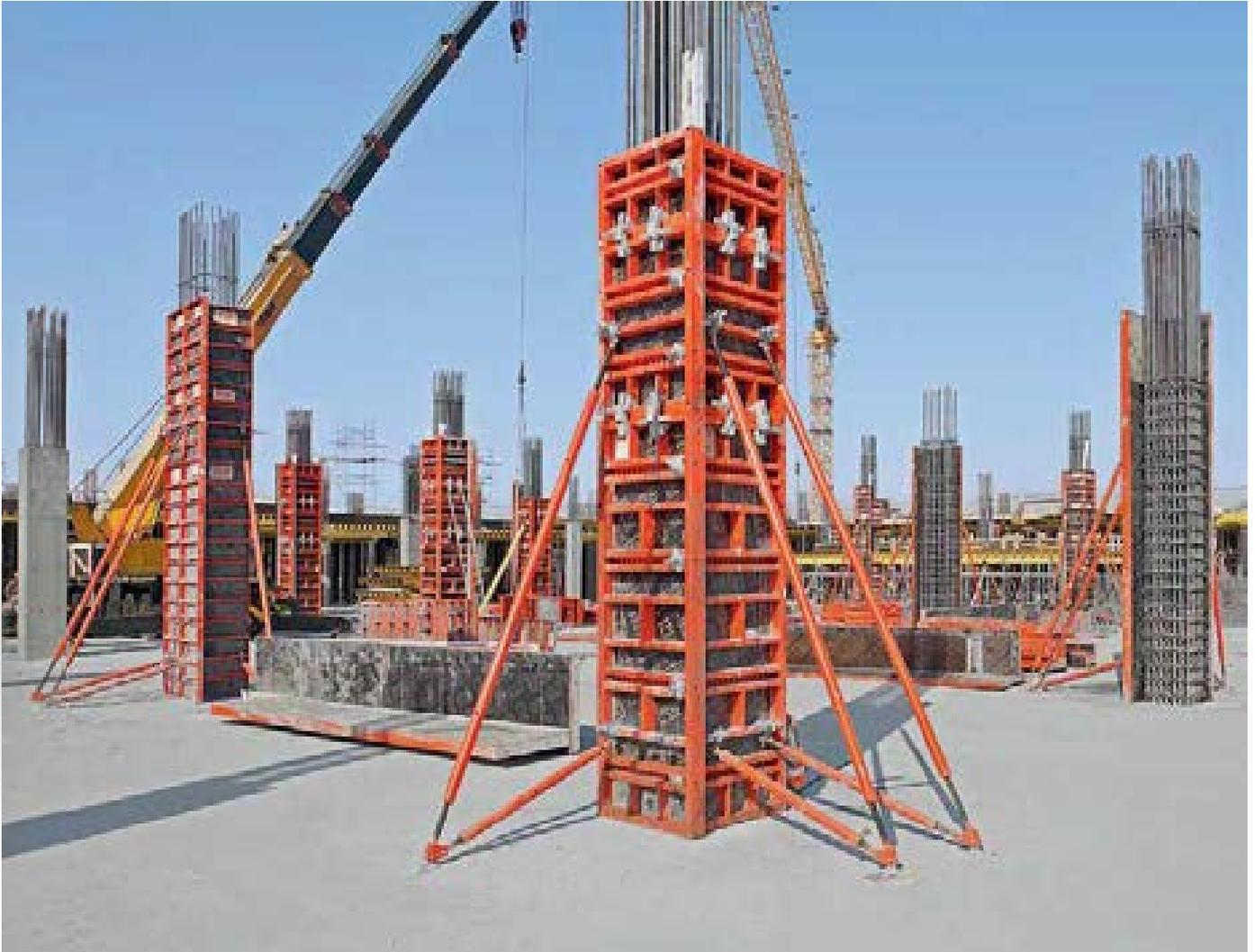
Колонны можно построить, используя 3 высоты, с наращиванием по 30 см. Замки BFD соединяют элементы колонны при расширении.
