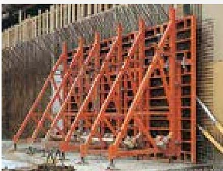
Комплект опорных рам SB-B и SB-C вместе с рамной опалубкой PERI TRIO. Высота бетонирования 3,50 м.
