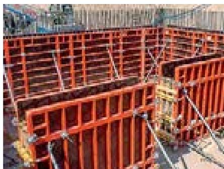
Временные опалубочный элемент с деревянным бруском и заполняющими листами: на лицевой стороне стена опалубливается вместе с выпрямляющим запором. Временная опалубочная связь передает нагрузку на рамную опалубку.
