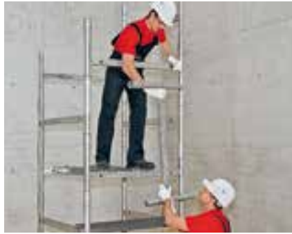
Установить соответствующее количество штапельных рам.
