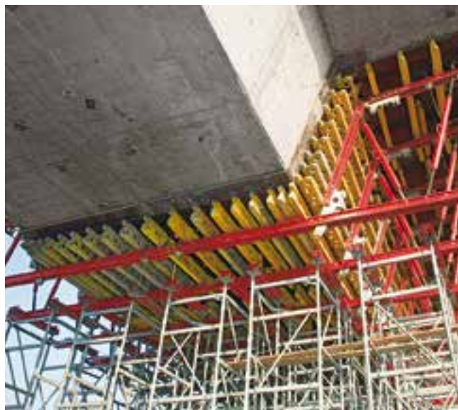
Стропильные элементы крепились с помощью анкеров к пролетному строению моста, что позволило демонтировать несущую конструкцию по частям для использования в следующем цикле.
