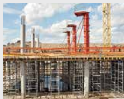
Штапельная башня PERI обладает достаточной несущей способностью без диагоналей. (Учитывайте результаты типового испытания).
