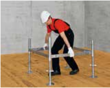
При установке базовой рамы нижние шпindelы необходимо правильно выставить и нивелировать.
