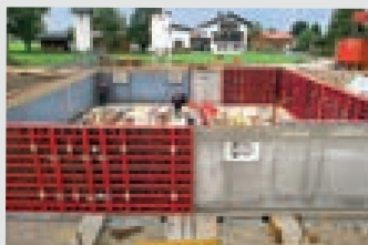
Стенная опалубка
