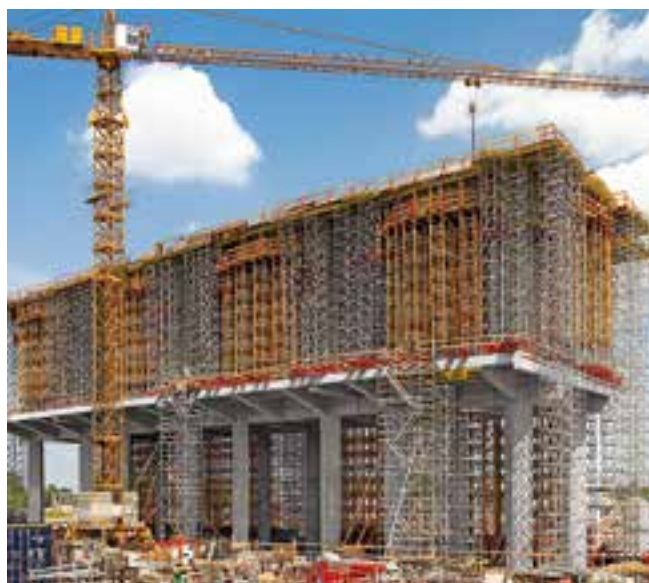
Штапельные башни ST 100 идеально сочетаются с модульной системой MULTIPROP. Стальные ригели SRZ и SRU из стеновой опалубки VARIO, предоставляемые в аренду, использовались для распределения нагрузки.
