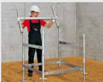
Вес рамы составляет менее 7 кг, что обеспечивает эргономичный и быстрый монтаж.
