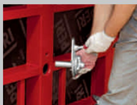
Установите шарнирную гайку MX на первичную опалубку и затяните болт с помощью ключа для тяжей MX.
