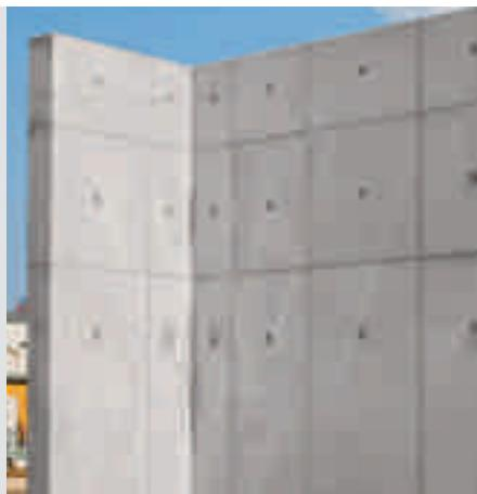
Внутренние углы 60/60 используются для архитектурного бетона, непрерывных стыков, при наличии тяжей непосредственно в углах или при использовании уплотнительных конусов MX 55 для оформления точек анкеровки.
