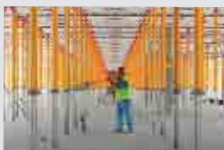
Опалубка для перекрытий
