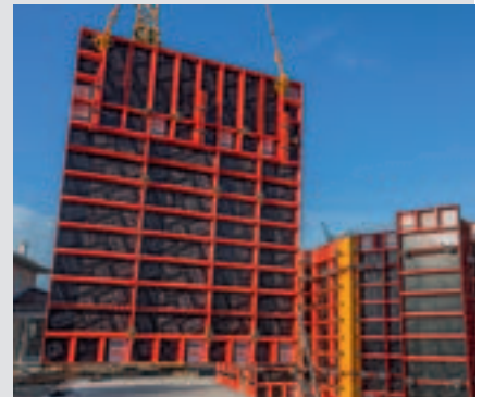
Горизонтальные элементы LIWA предназначены для наращивания конструкции по высоте до 3,85 м. Выравнивающий ригель обеспечивает конструктивную жесткость собранных щитов.
