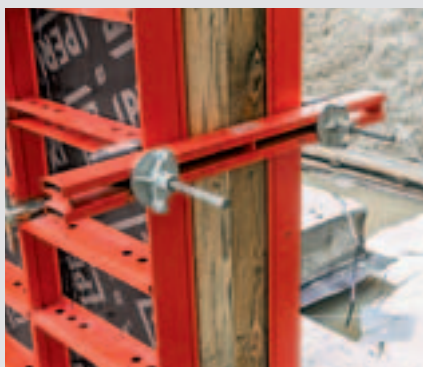
Простая торцевая опалубка монтируется с помощью брусков и фанеры.
