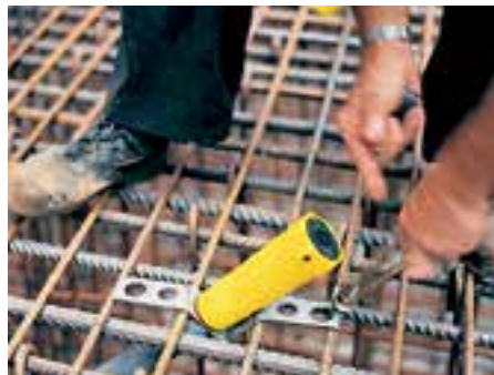
Простое крепление анкеров к арматуре: с помощью клещей и проволоки.
