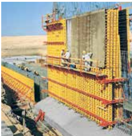
Применение VARIO GT 24 при строительстве очистного сооружения с коническими стенами.
