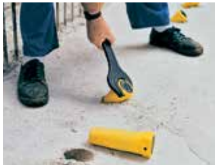
Демонтаж муфты-фиксатора с помощью гаечного ключа SW 70.
