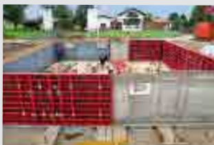
Стеновая опалубка
