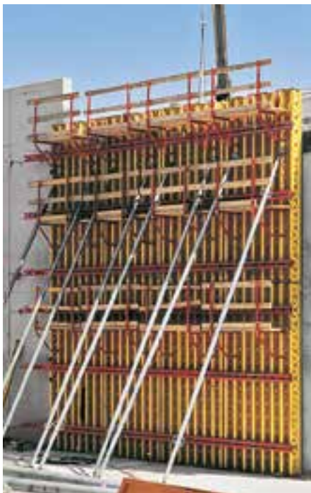
Нарращенные элементы системы VARIO GT 24 при возведении административного здания.
