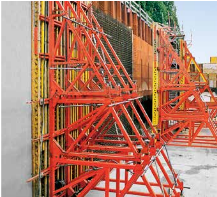
Высота бетонирования макс. 8,75 м. Опорные рамы A0, A, B, C и стеновая опалубка VARIO GT 24.
